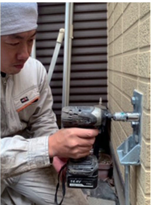
上) 補強金具 下) 外側から耐震補強します。
